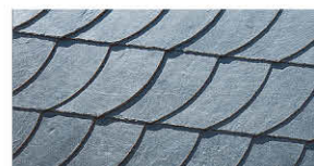
Вид укладки: SCHUPPENDECKUNG Тип плитки: SCHUPPEN
